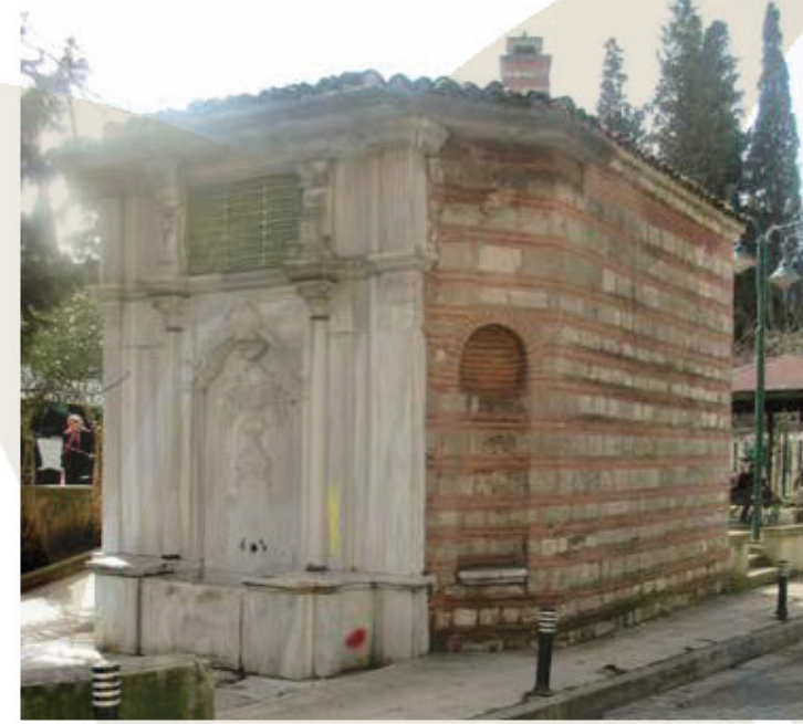
Mihrişah Valide Sultan Çeşmesi (Yan cephe)
