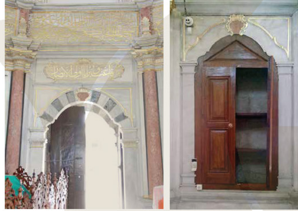
Türbe Giriş Kapısı ve Yanındaki Dolap
