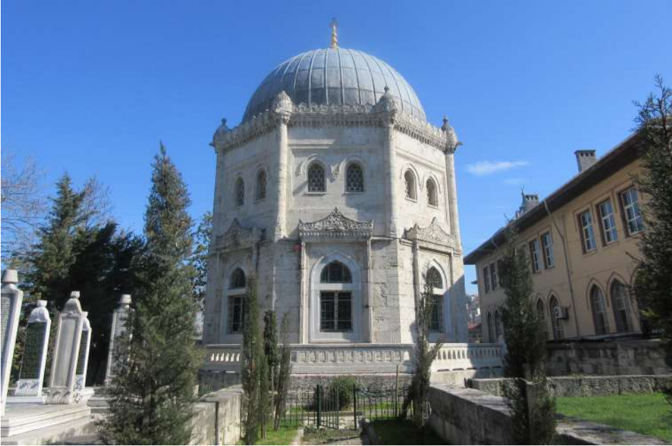
Sultan Reşad Türbesi Arka Cephesi
