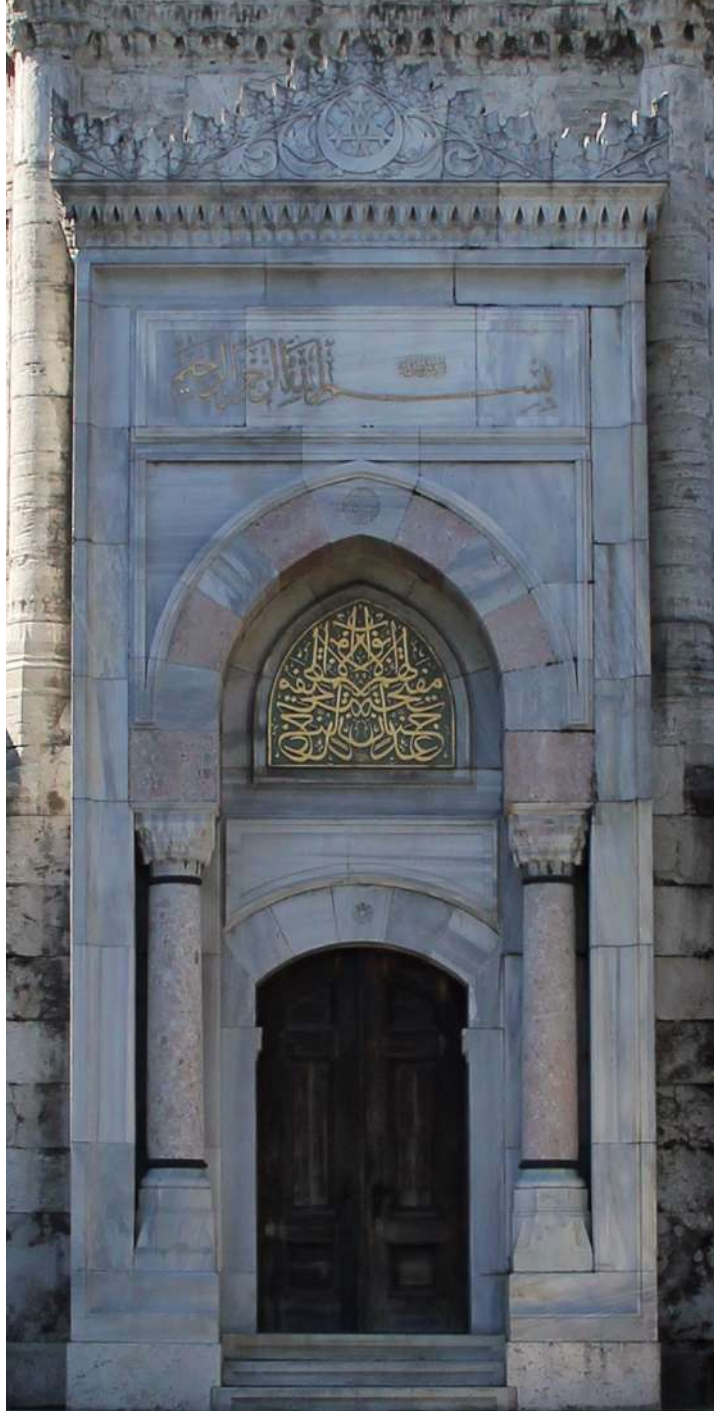
Türbe Giriş Kapısı
