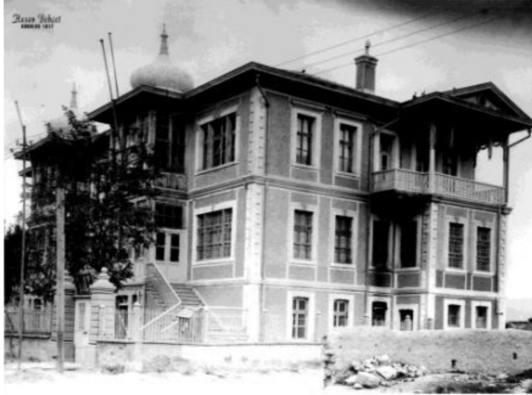
Enstitü binasının eski hali
