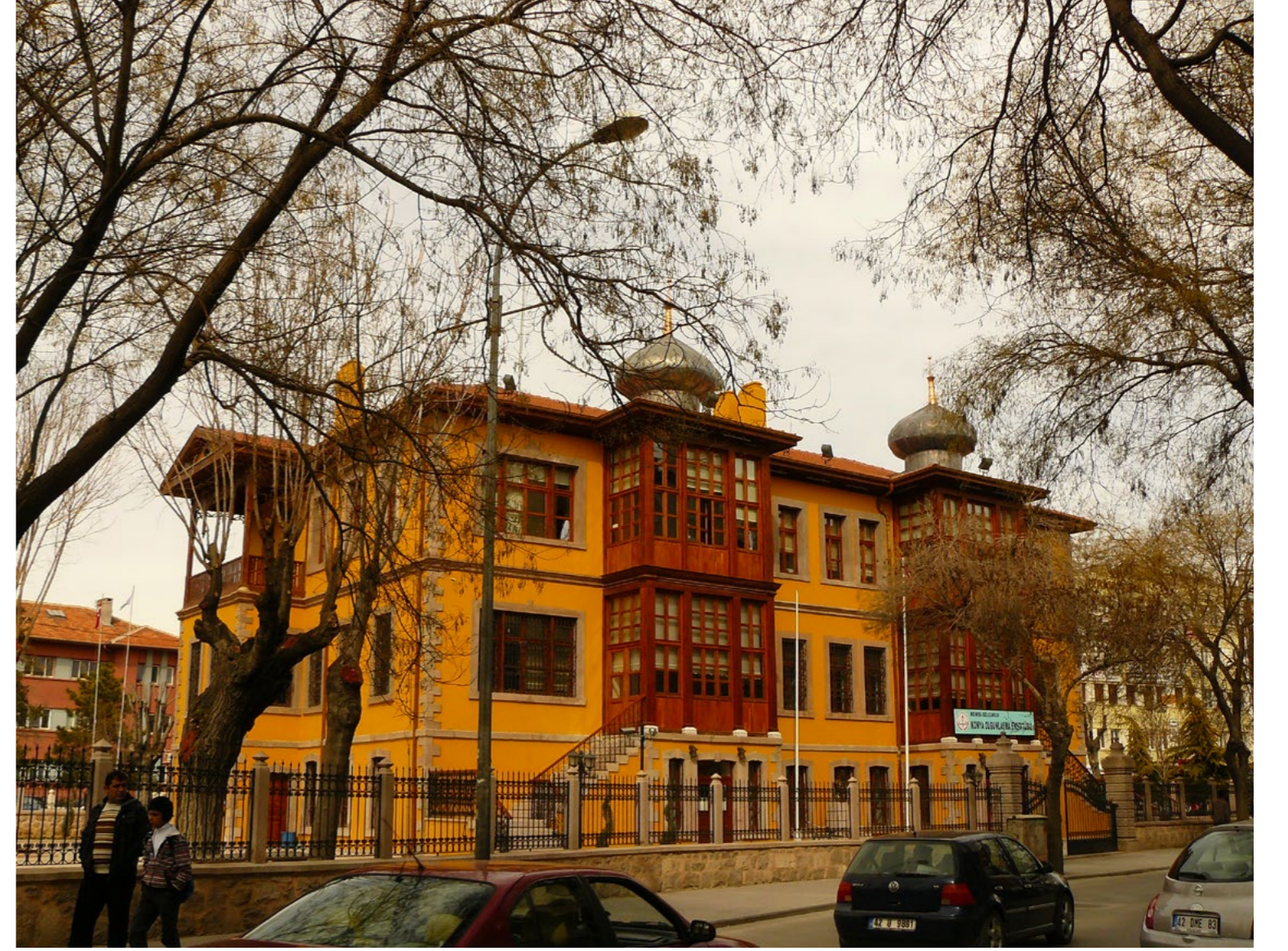
Restorasyondan sonra enstitü binası
