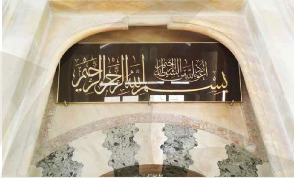
Yavuz Sultan Selim Türbesi'nin Ana Giriş Kapısı Üzerindeki Bursa Kemer
