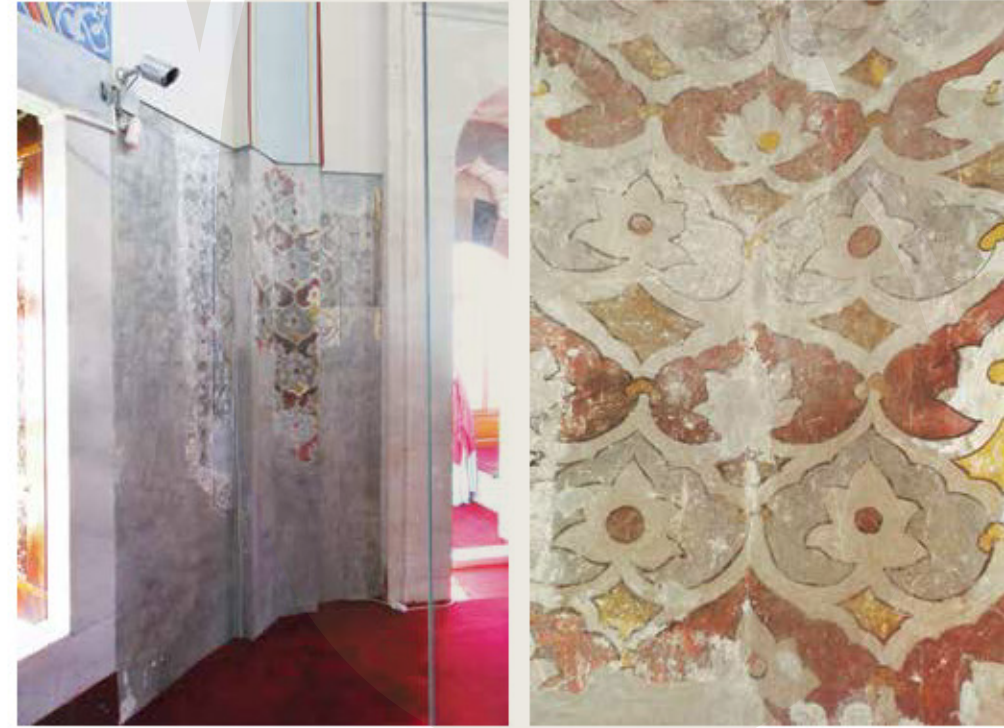
Yavuz Sultan Selim Türbesi Giriş Kapısı Yanı Kalemîşi Restorasyonu
