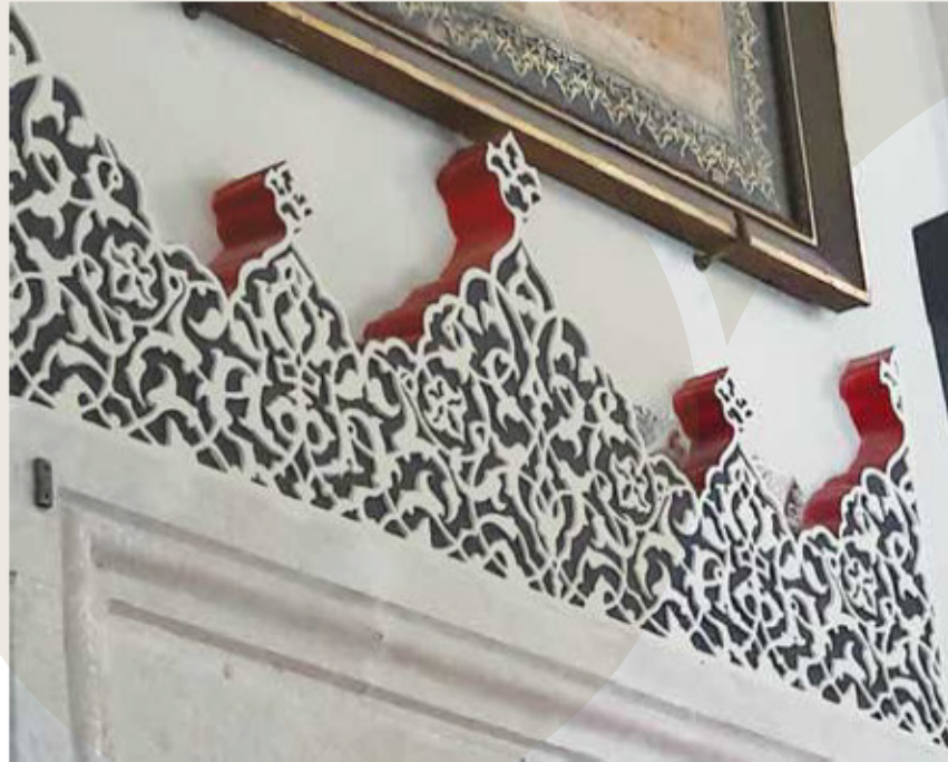
Restorasyon Sonrası İç Kapı Hotozu
