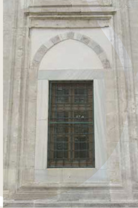
Yavuz Sultan Selim Türbesi Dış Cephe Alt Sıra Penceresi
